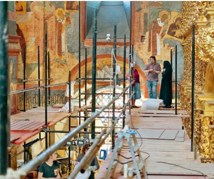
Реставрационные работы в Смоленском соборе (слева)
